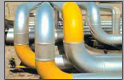
Pruebas de Tuberías
